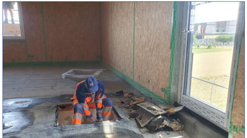
Die (ehemaligen) Lichtkuppeln am (ehemaligen) Flachdach werden verschlossen und ausgegossen.
